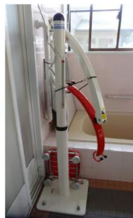
入浴リフトを取り付け
